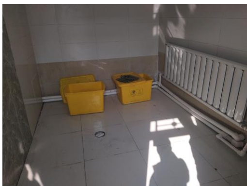
医疗废物暂存间
