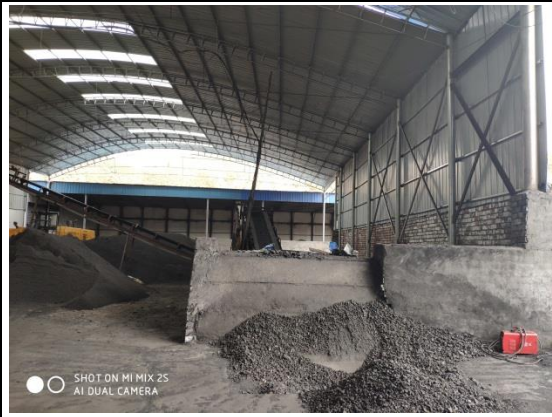
半封闭筛分车间
