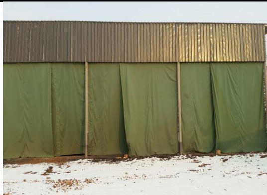
半封闭煤堆场
