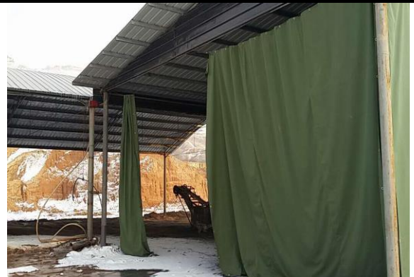
半封闭煤堆场
