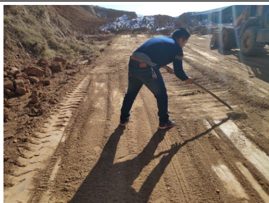
粘土露天采场平整情况
