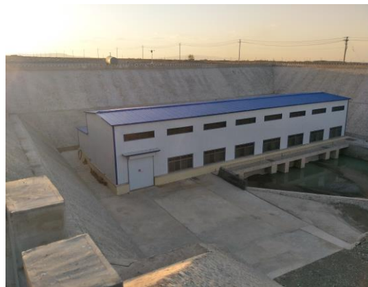
水电站发电厂房外景
