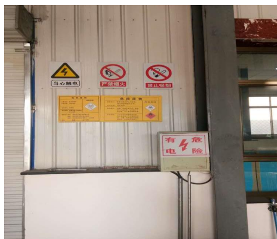
危险废物暂存间
